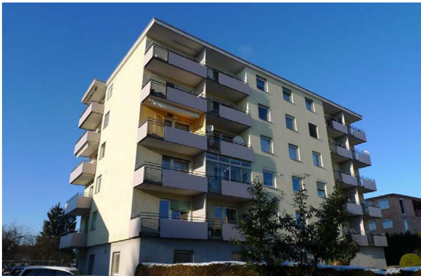
Foto: Többlakásos ház EPS homlokzati hőszigetelő rendszerrel (1966-ban építve)
