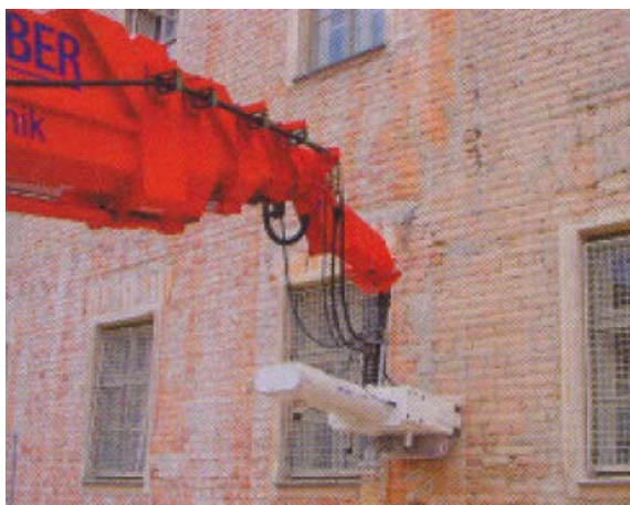
Foto: Homlokzati marógép munka közben
