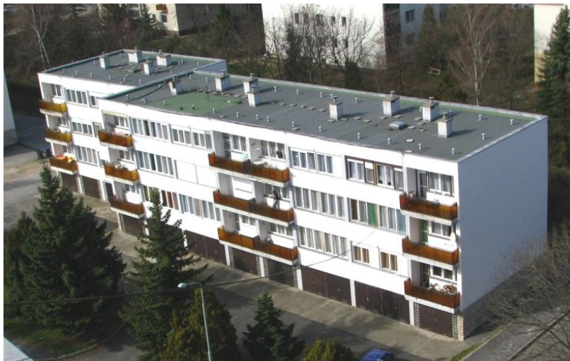
Az épület felújítás előtt
