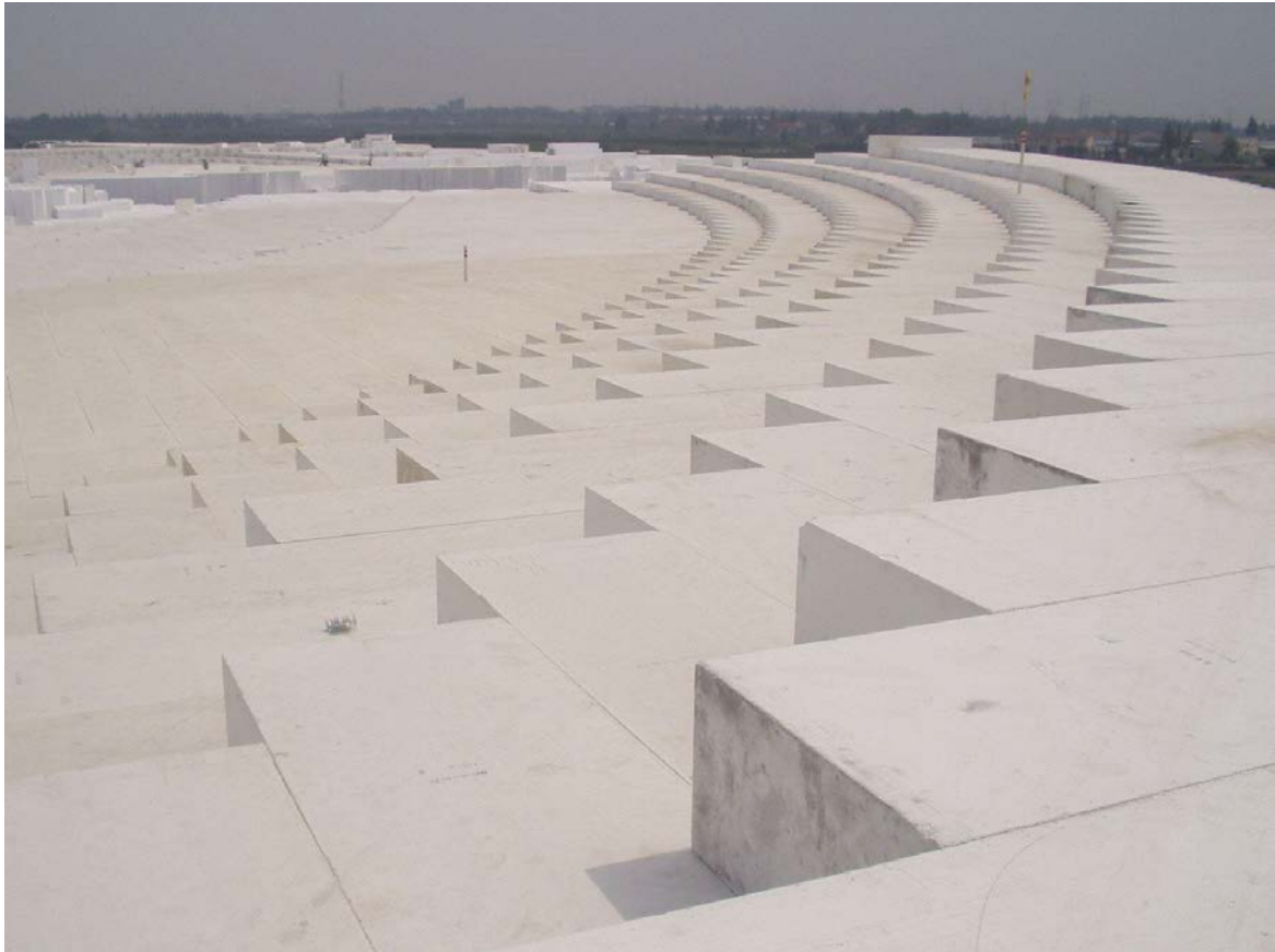
Foto: Forma 1-es tribünök Sanghajban építés alatt
