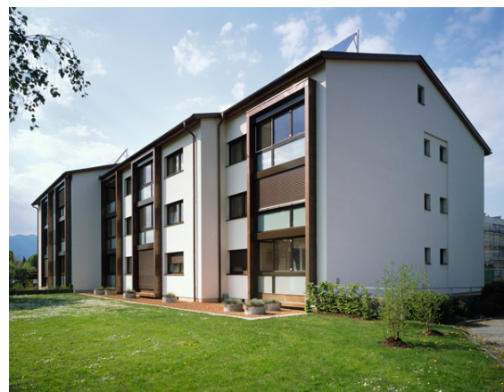
Foto: Lakóépület Rankweil-Schleipfweg felújítás után
