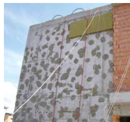
3. kép: Meghibásodás okai sorrendileg: 1. kötélről végzett THR-építés 2. a friss vb. szerkezet még nedves 3. hibás ragasztási kép 4. szakszerűtlen ragasztófelhordás MW-re 4. védelem hiánya
