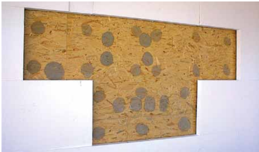
4. kép: OSB-re nem alkalmas ragasztó + hibás ragasztási kép
