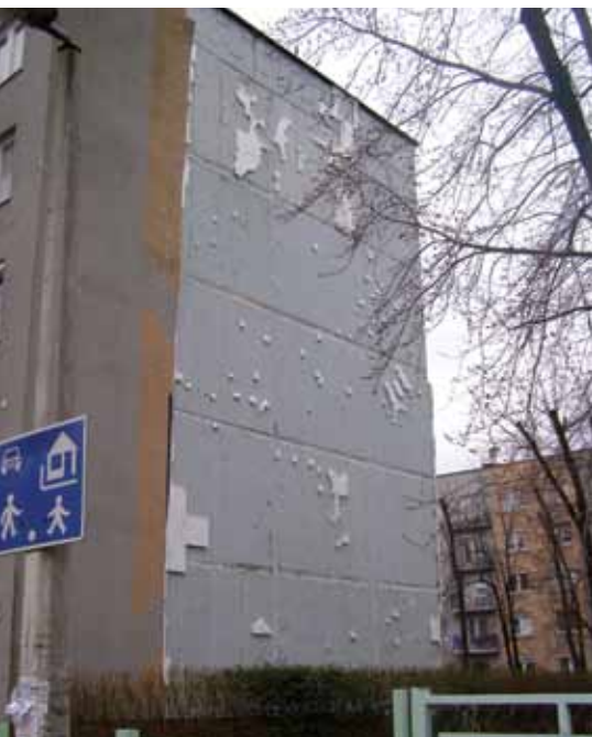
1. kép: THR-leválás okai sorrendileg: 1. alapfelület tisztításának hiánya 2. szabálytalan ragasztás 3. dübelezés hiánya
